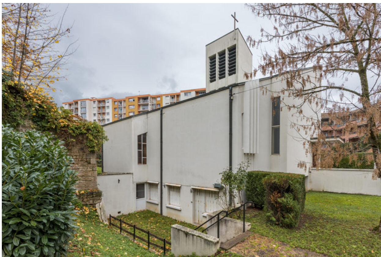
Vue de la façade sud (de trois-quarts).
