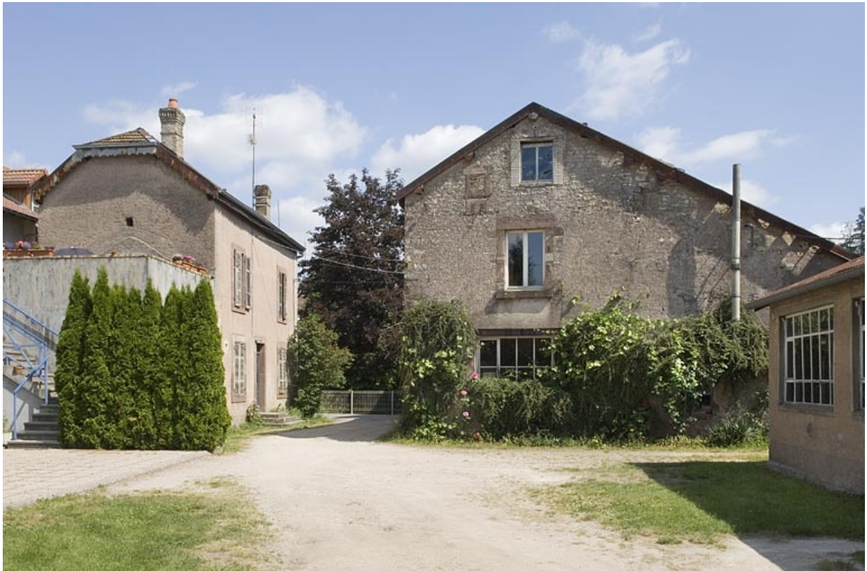
Logement et bâtiment du moulin.
