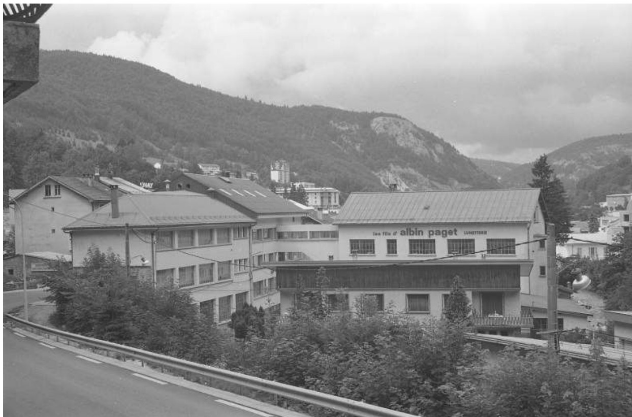
Bâtiments vus du sud.
