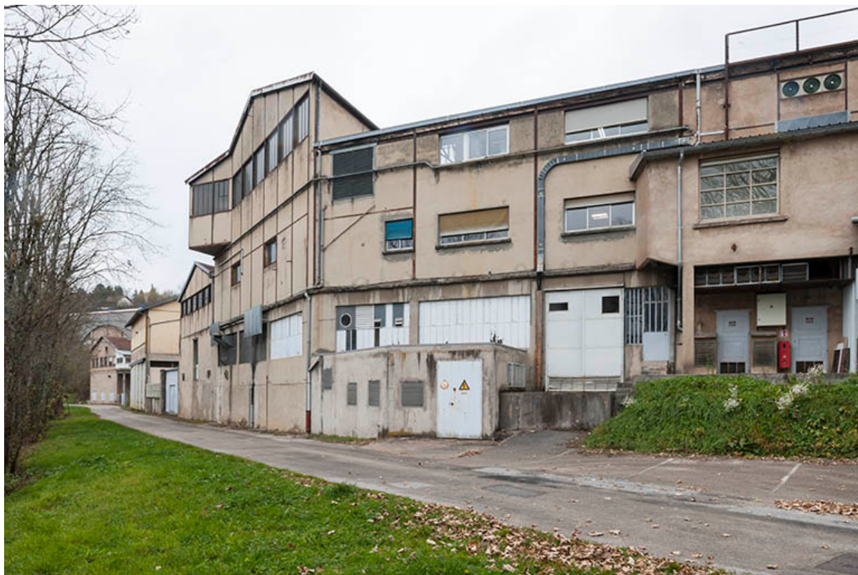
Façades sud de l'atelier de fabrication.
