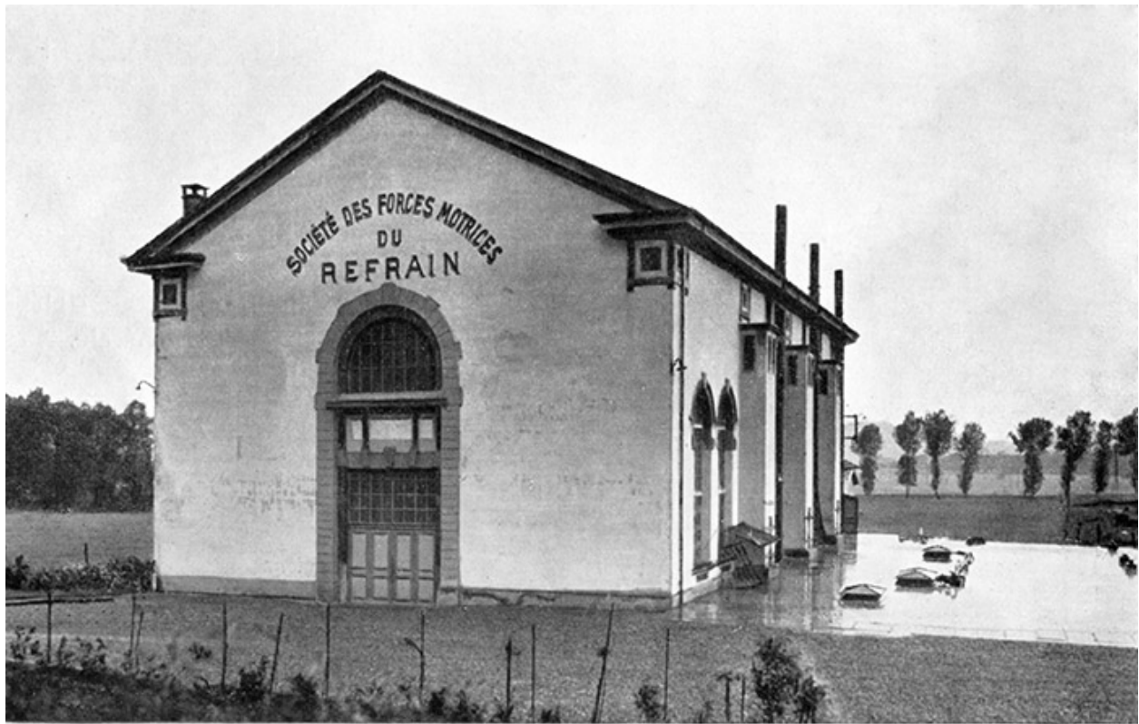
STATION DE SECOURS D'ÉTUPES : Vue générale.
