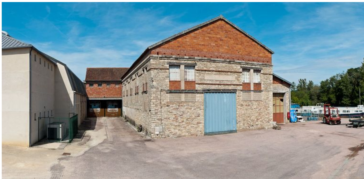
Vue de l'ancienne usine à chaux.
