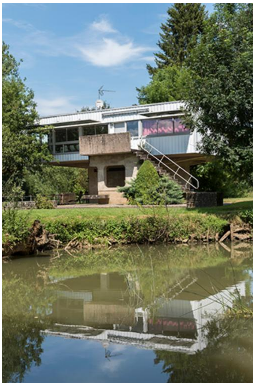
Villa Kielwasser, Chemilly.
