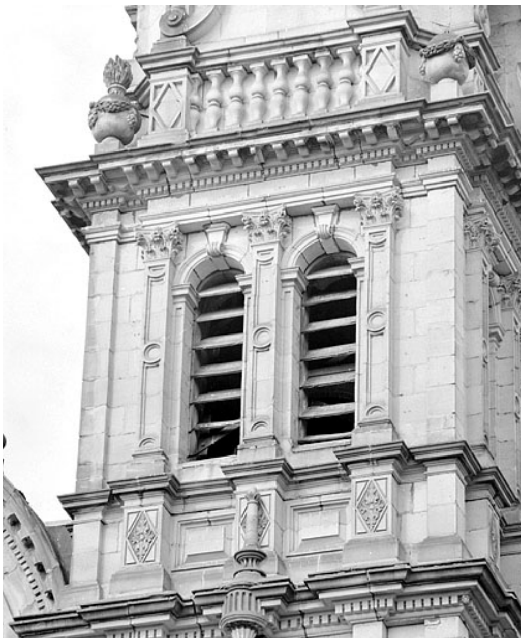
Troisième niveau de la tour nord.
