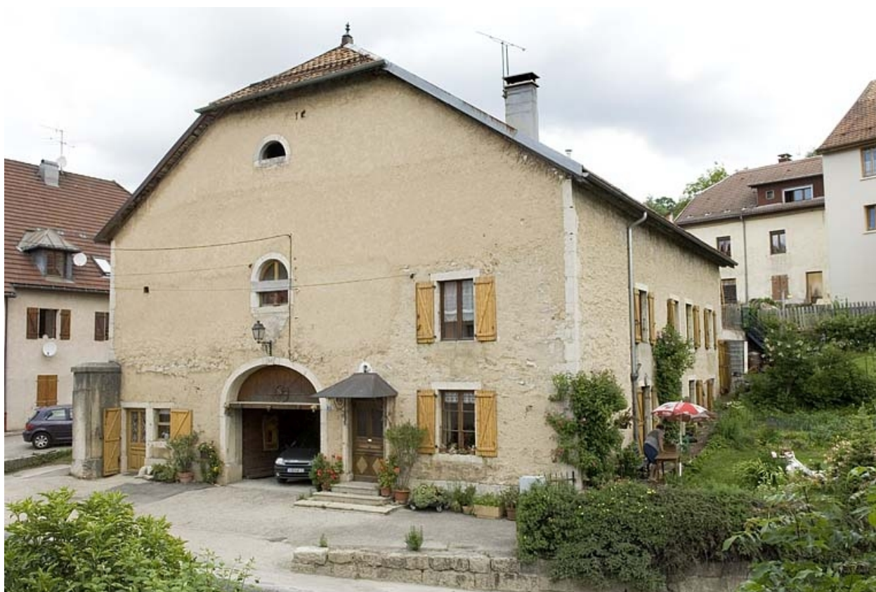
Façade antérieure, route des Alpes.
