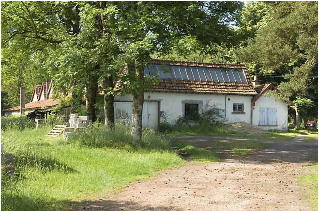
Vue d'ensemble depuis la route.
