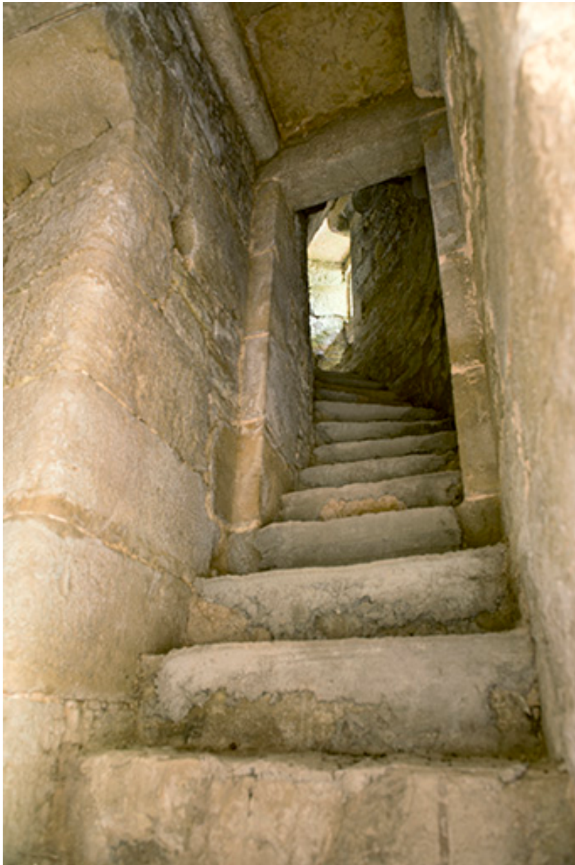
La tour ouest. Vue intérieure de l'escalier.
