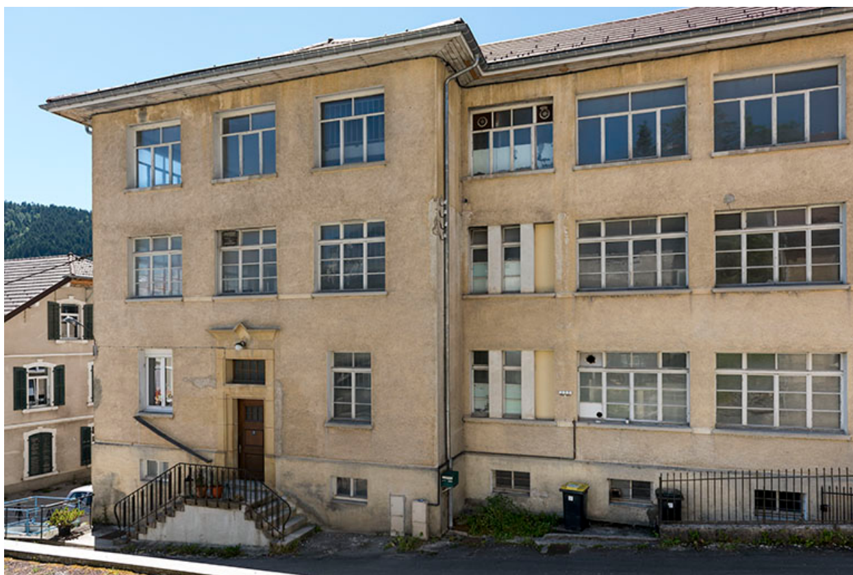
Usine : façade antérieure.
