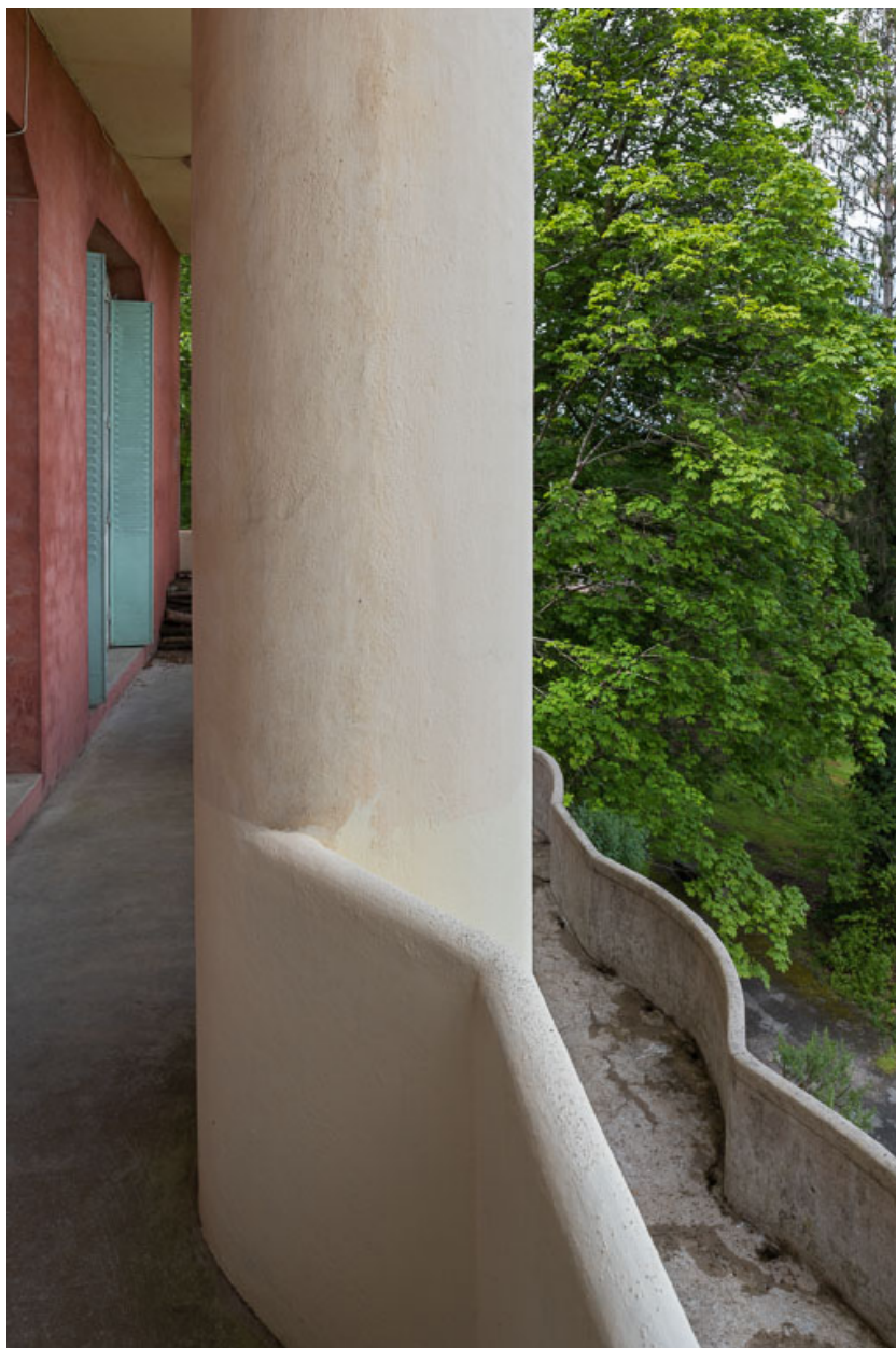
Balcon de la façade nord.
