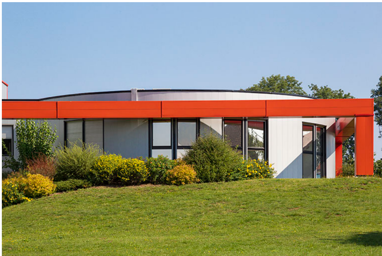
Façade postérieure : bureaux.
