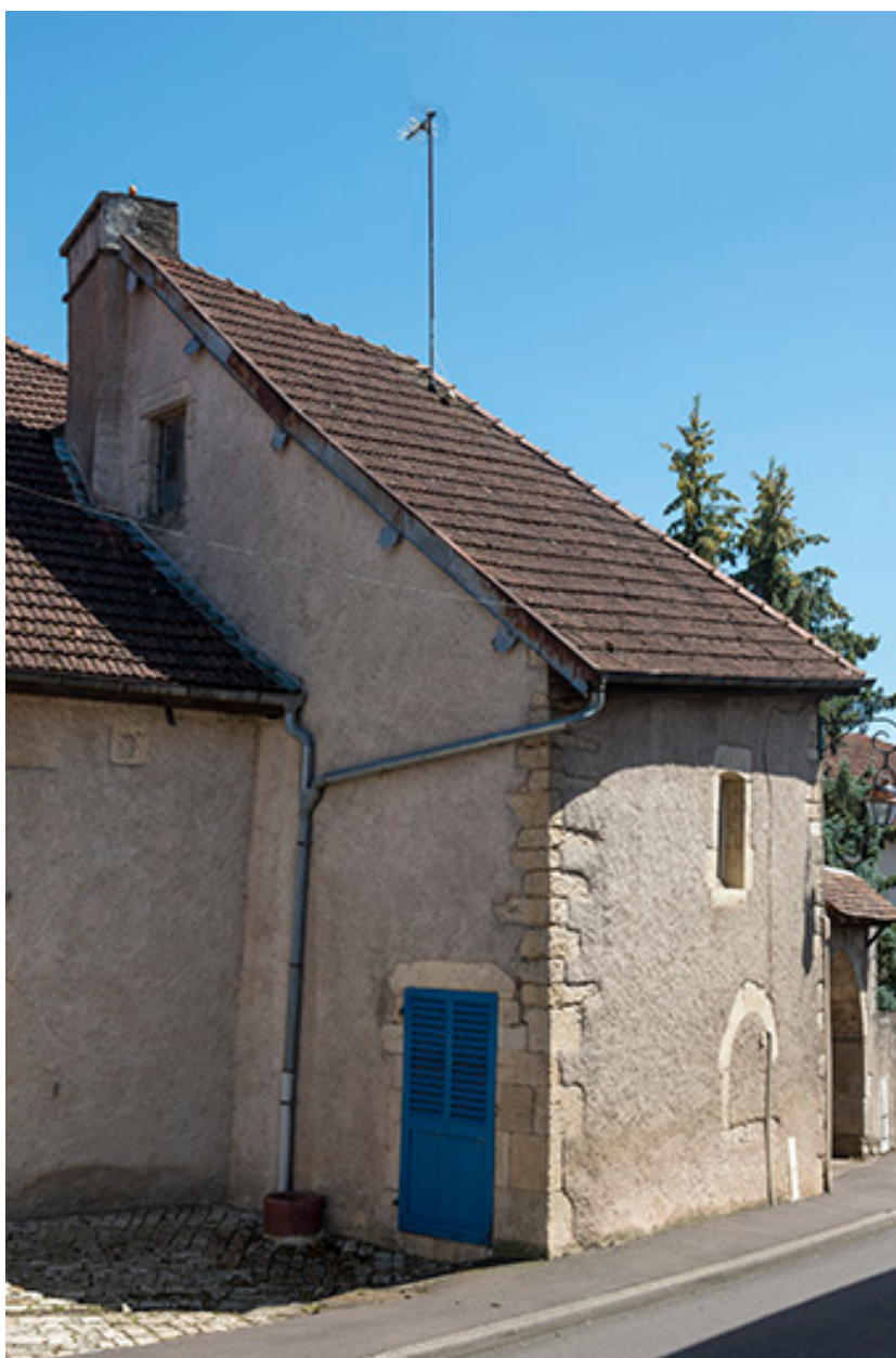
Façade antérieure, partie sud.
