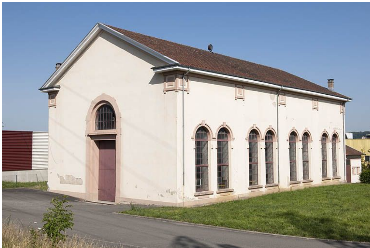
Salle des machines.
