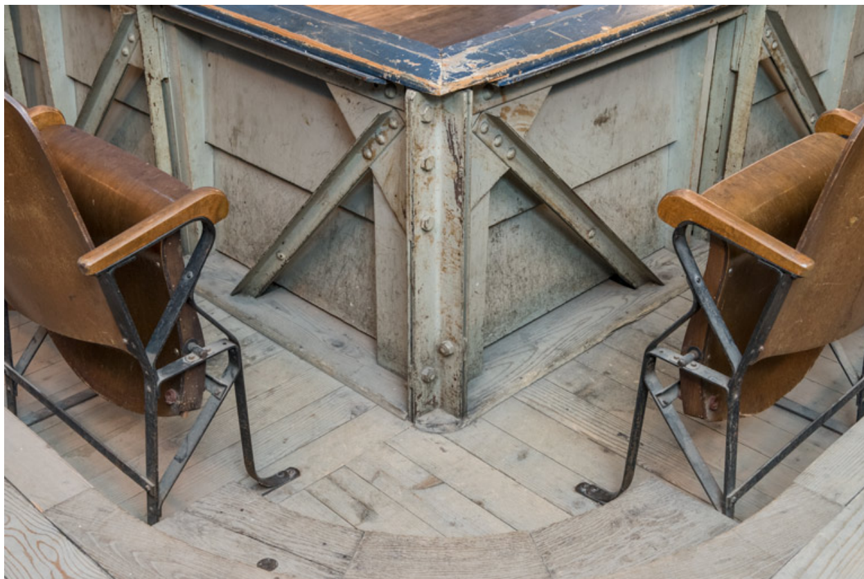
Balcon : structure métallique du garde-corps.
