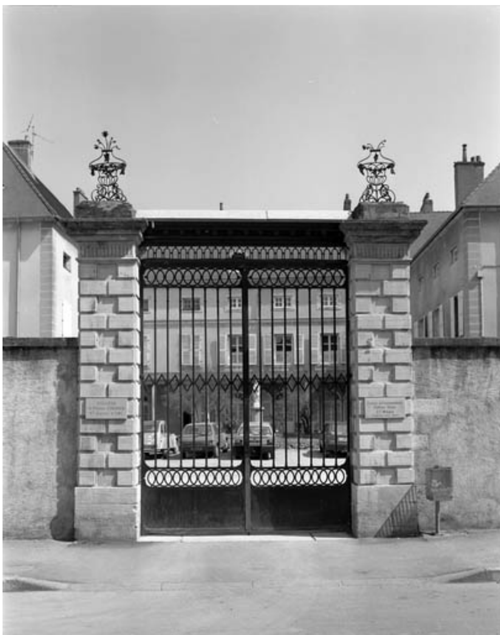
Détail du portail d'entrée, grille fermée.
