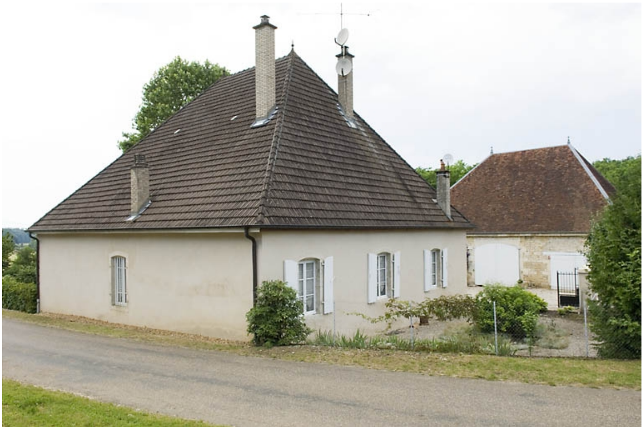
Logement patronal et haut fourneau.
