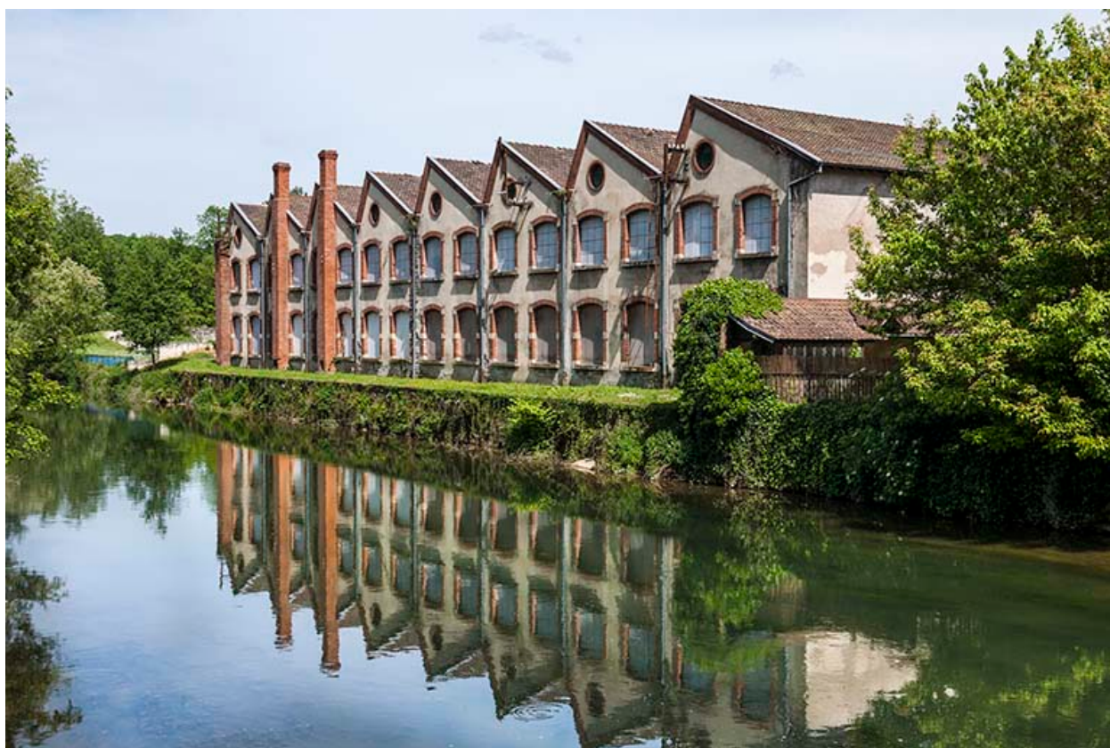
Façade ouest de l'atelier de fabrication.
