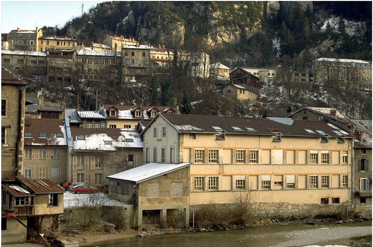
Façade postérieure de l'usine.
