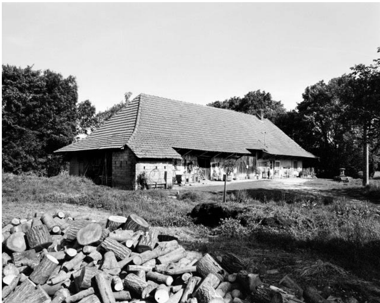
Ferme située au lieudit Vizent : vue générale.
