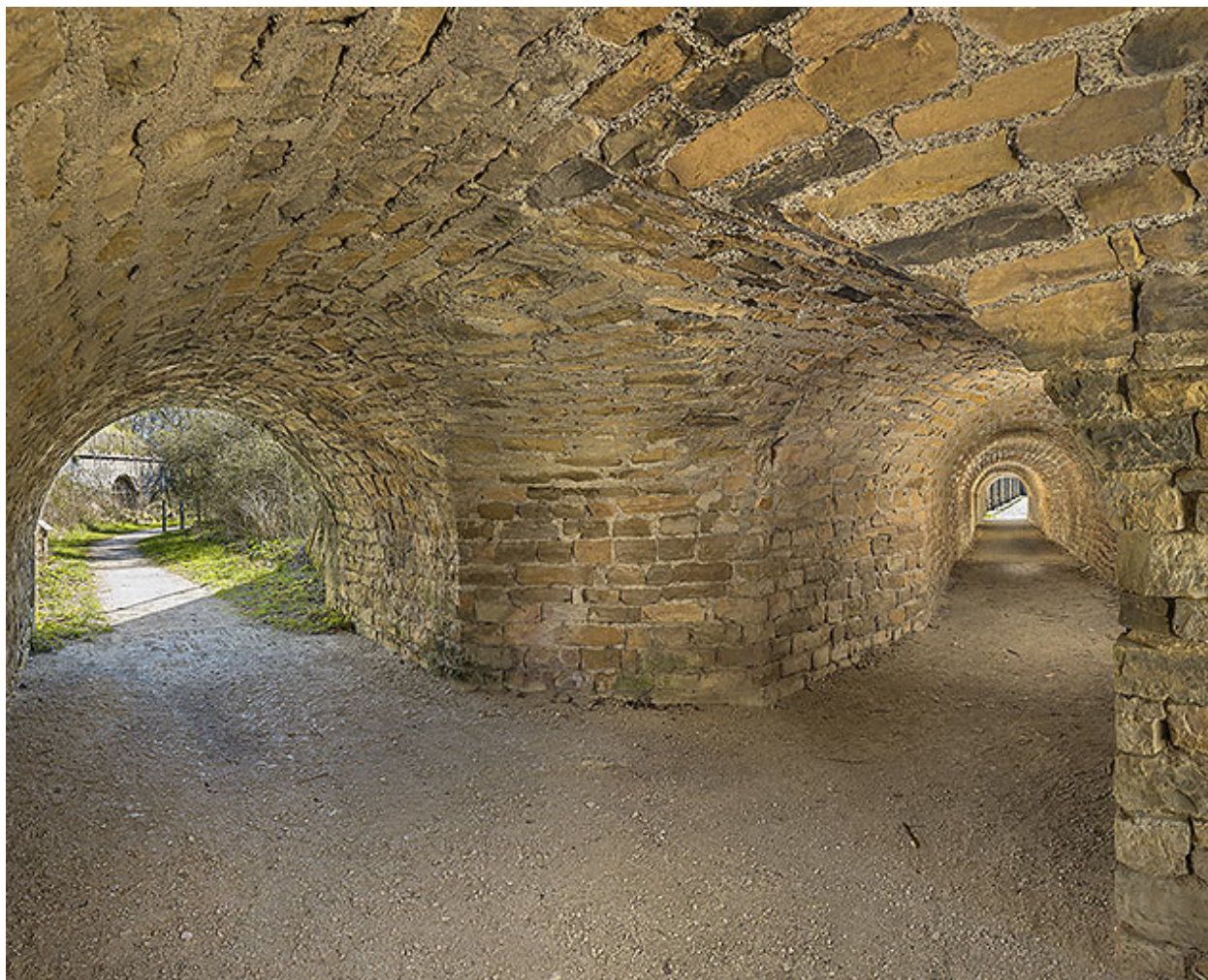
Galleries couvertes et accès vers la rue des Remparts (à gauche).
