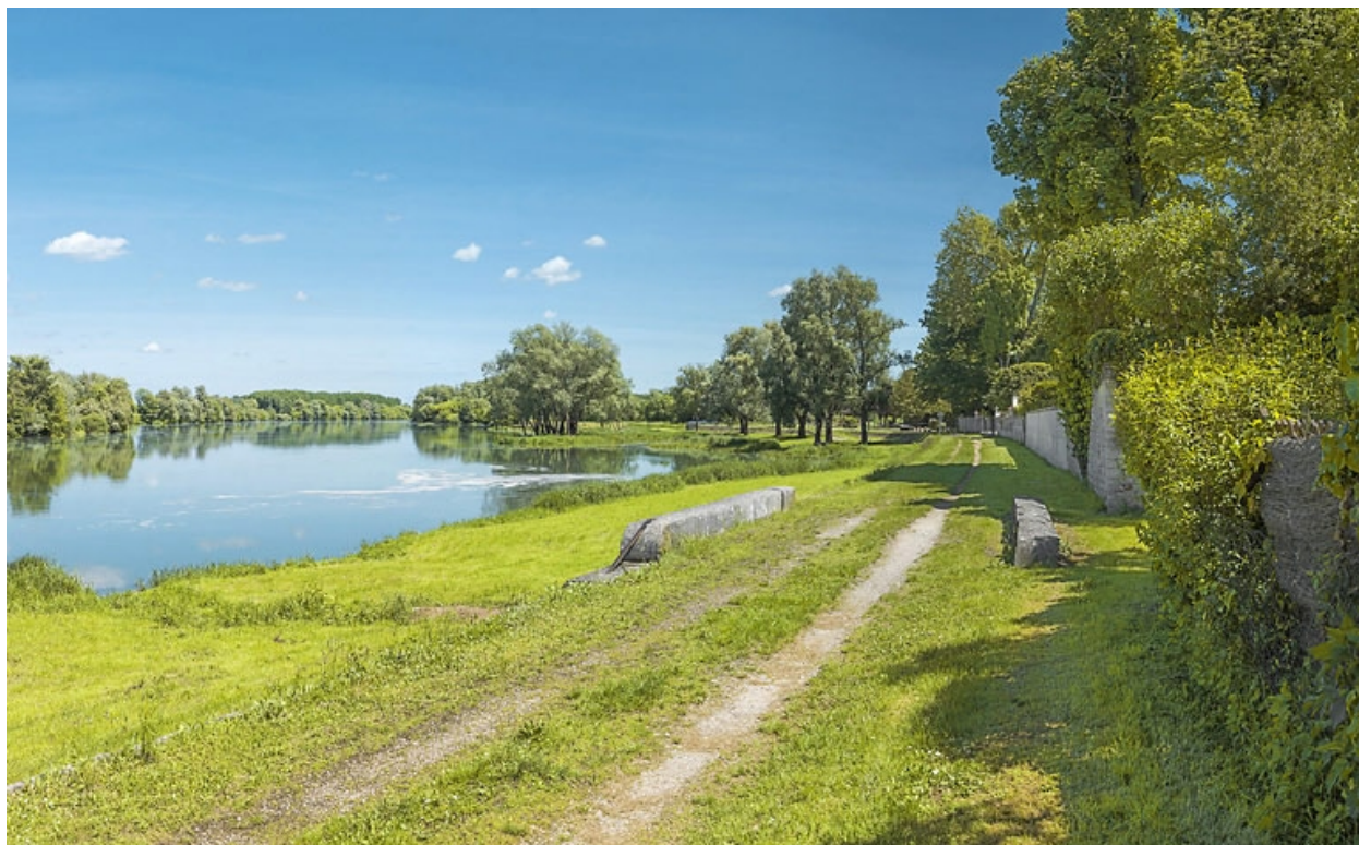
Le deuxième ponceau, vu d'aval.
