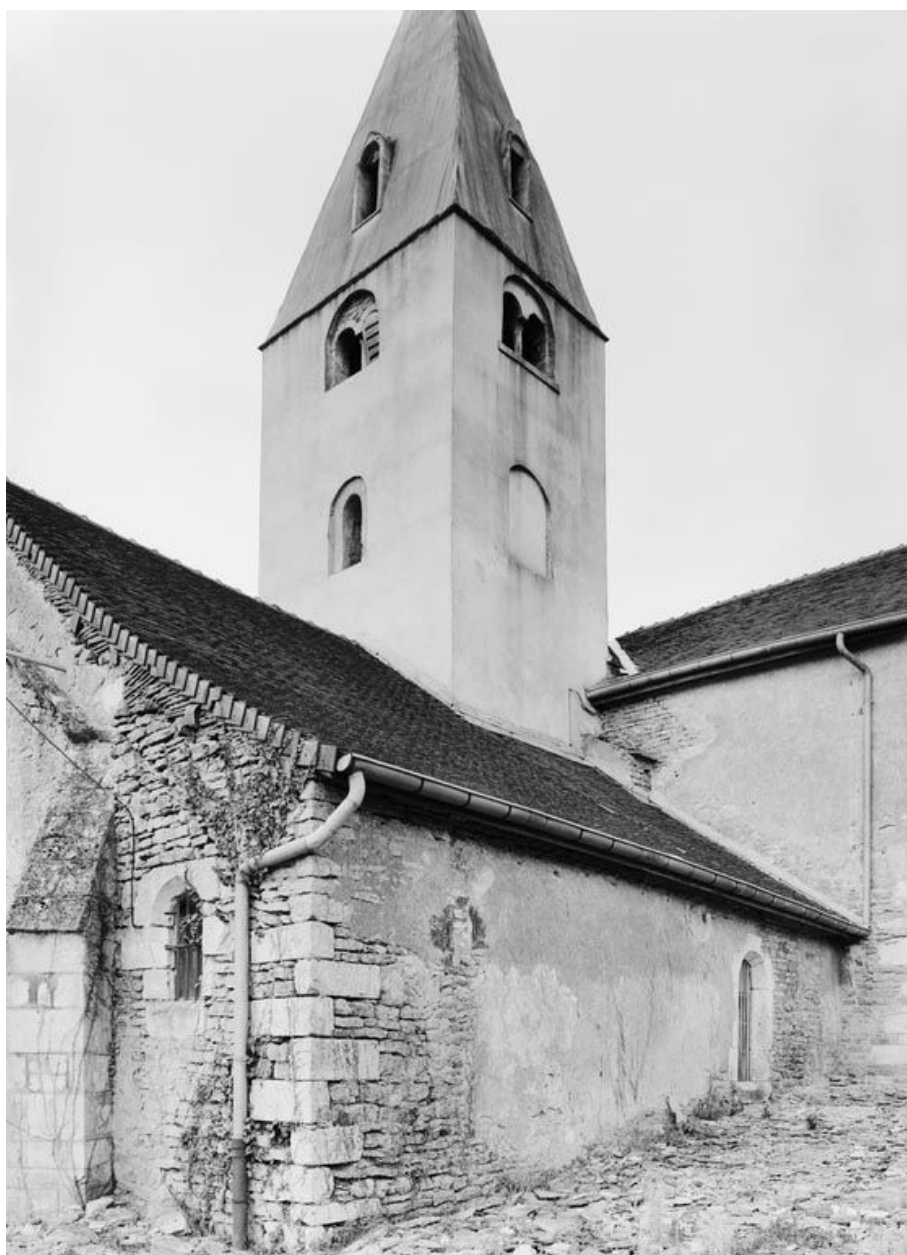
Elévation gauche du choeur et clocher.
