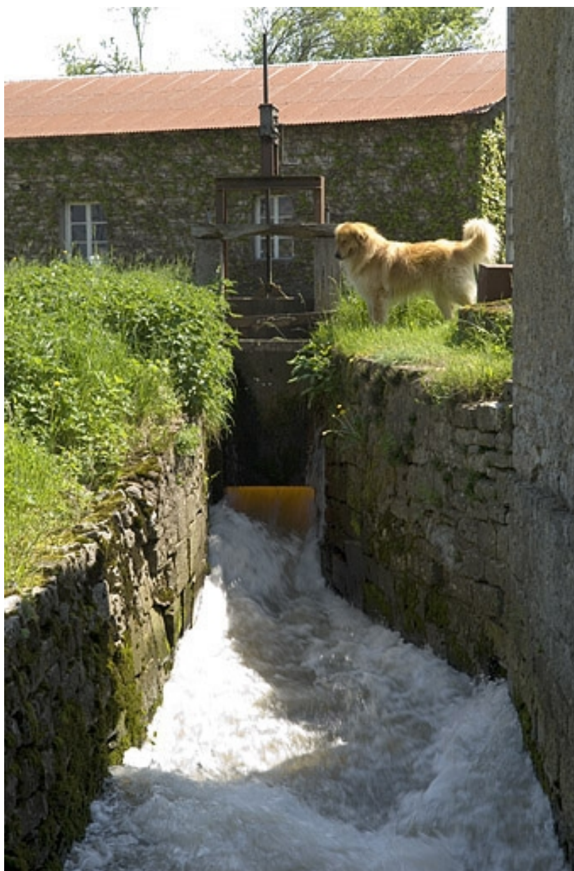
Bief d'amenée du moulin à huile.
