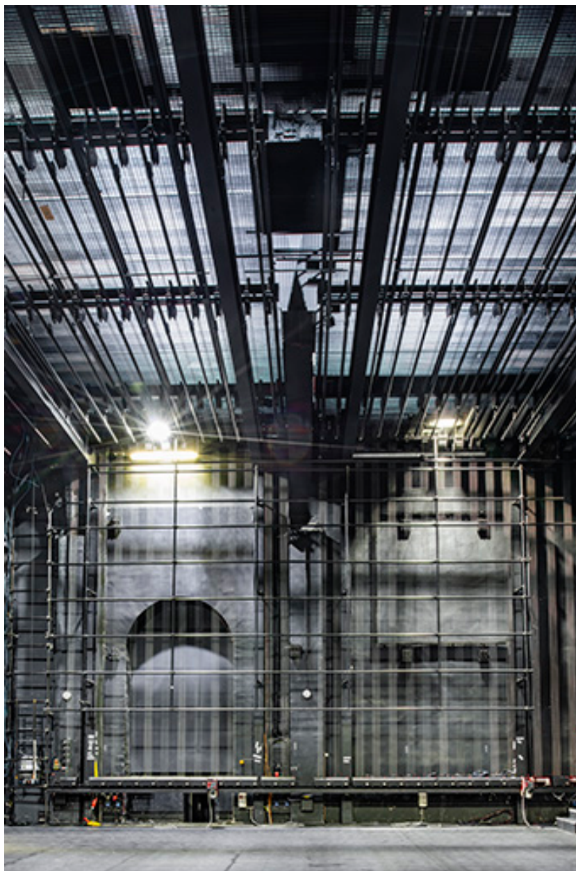
Salle, mur latéral nord-ouest, vue de face.
