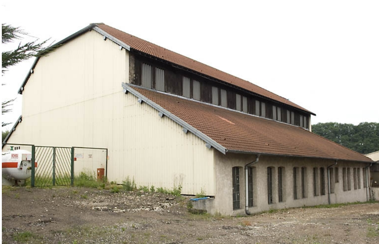
Atelier de fonderie depuis le nord-est.
