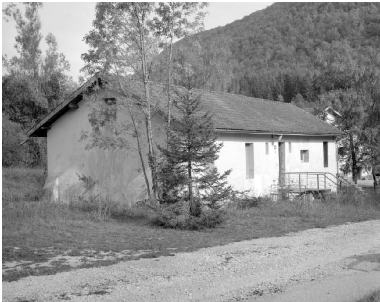
Logement d'ouvriers, vu de trois quarts gauche.
