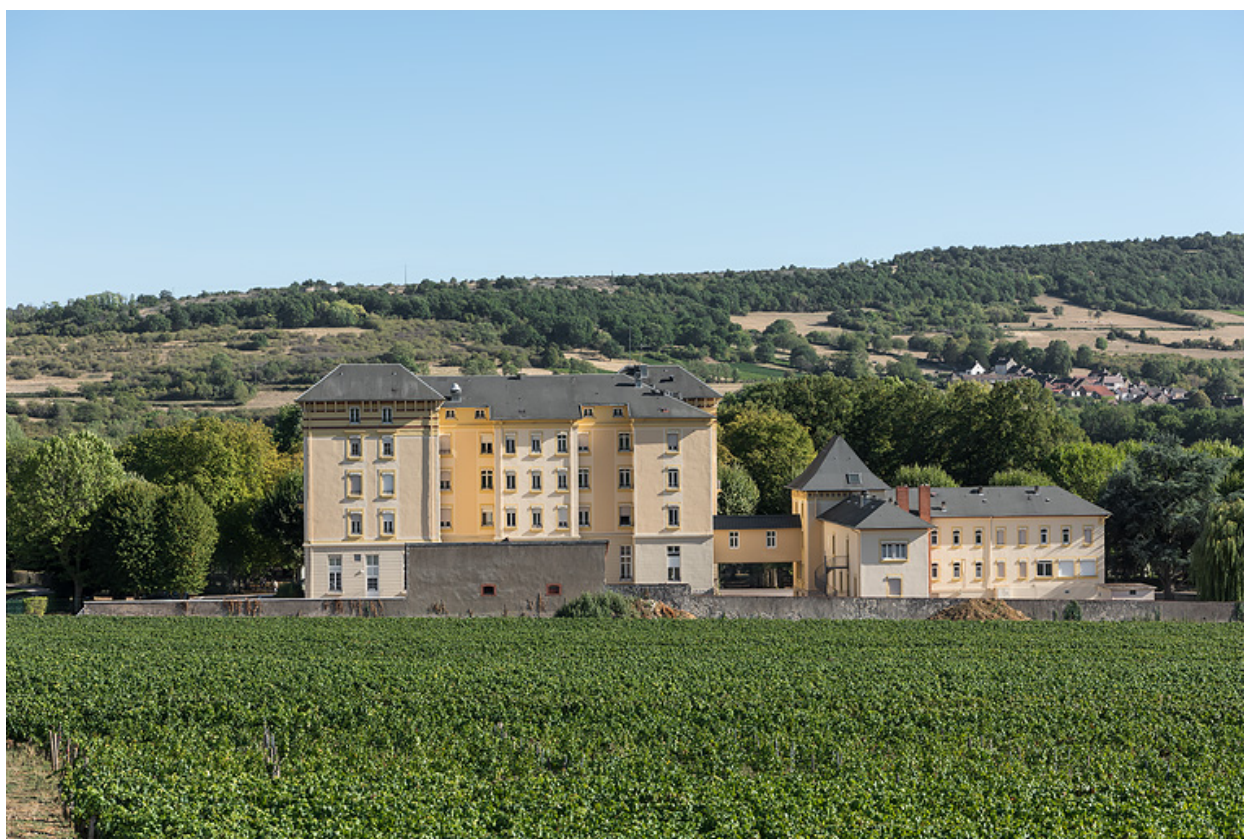
Vue de l'hôtel (à gauche) et du centre de soins (à droite) depuis le chemin du Potet.
