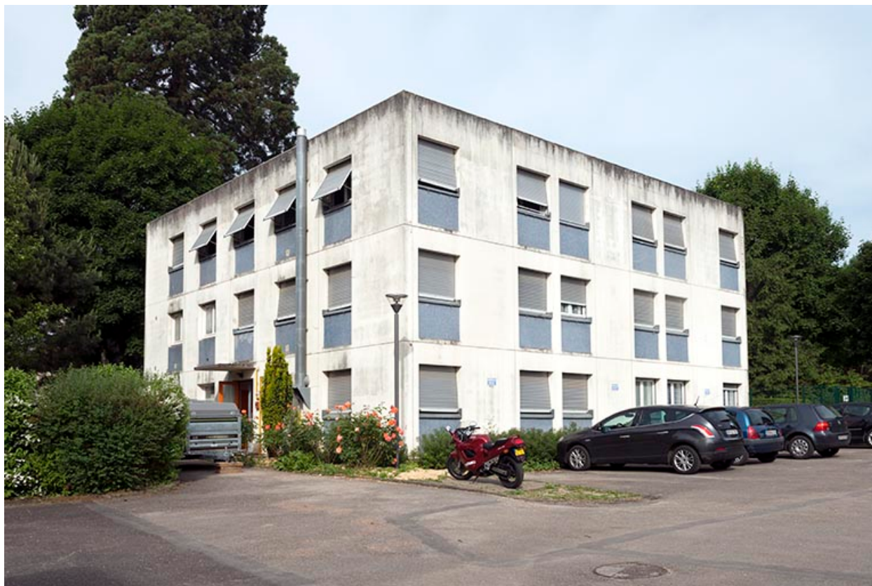
Angle sud des logements.
