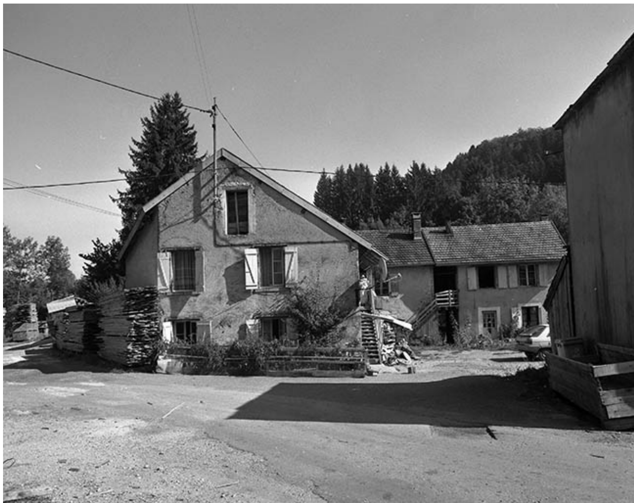
Logements d'ouvriers depuis l'ouest.
