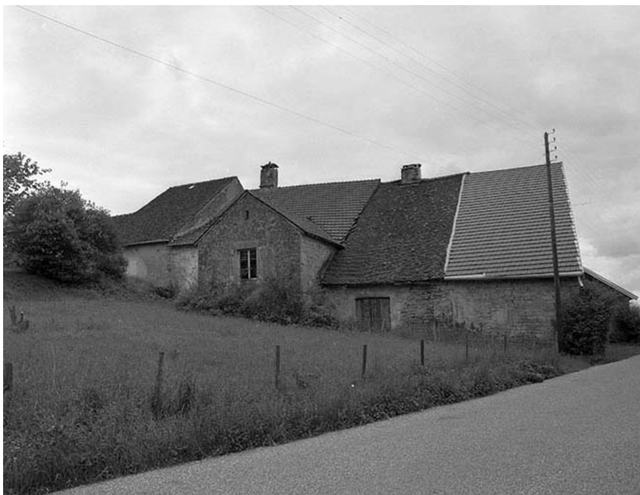
Façade postérieure avec les deux fermes voisines
