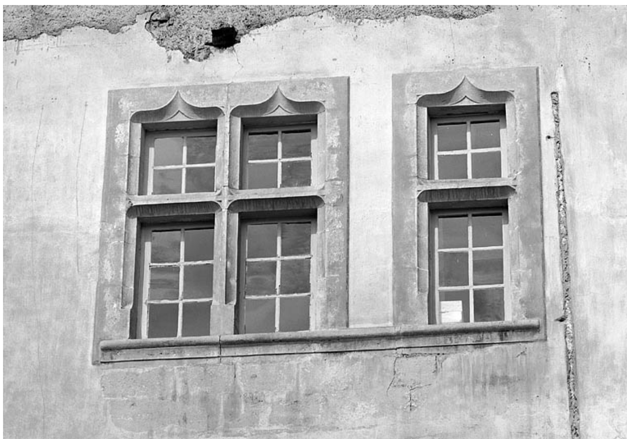
Fenêtres de l'étage de la face est.
