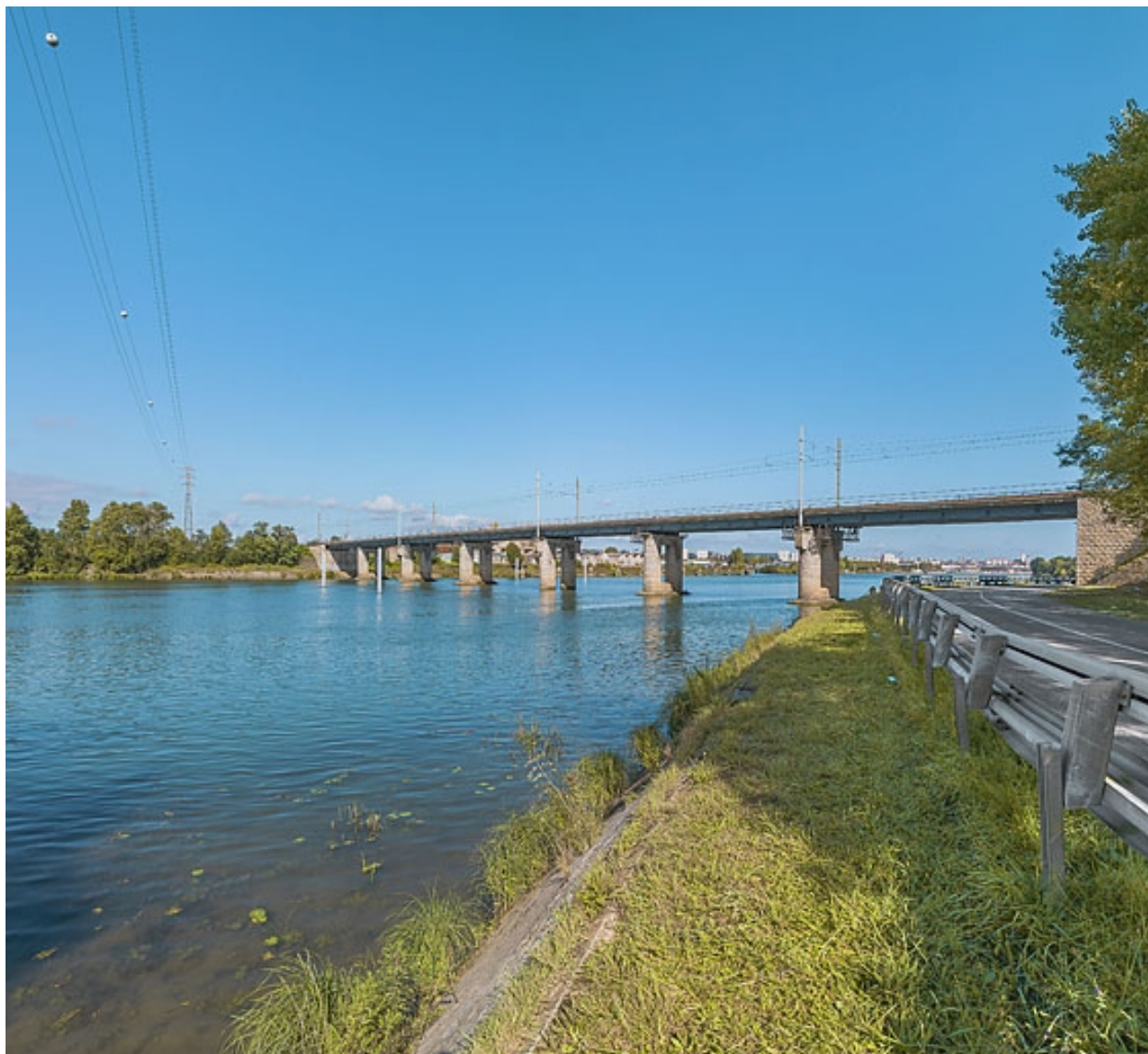
Le pont vu d'aval, rive gauche.
