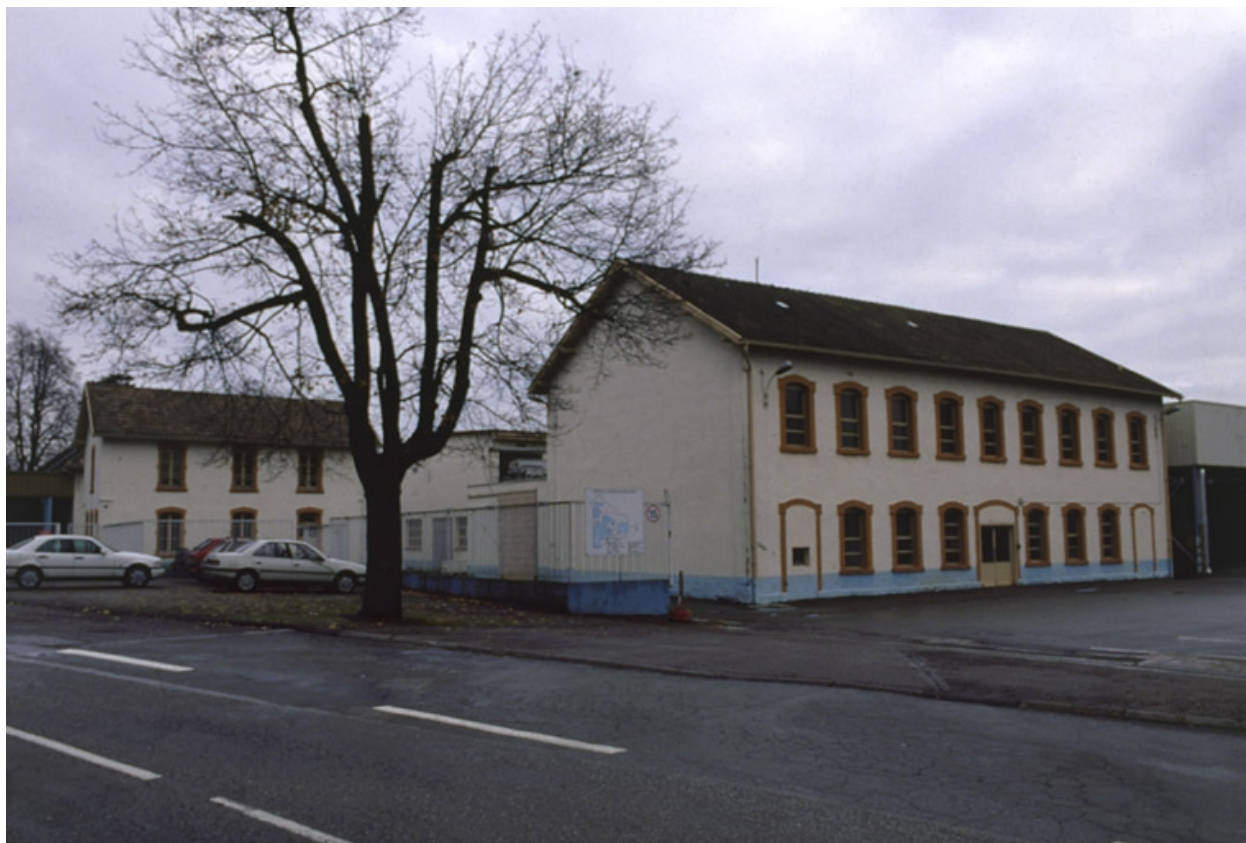
Bâtiments (bureaux ?) de l'usine de teinturerie.
