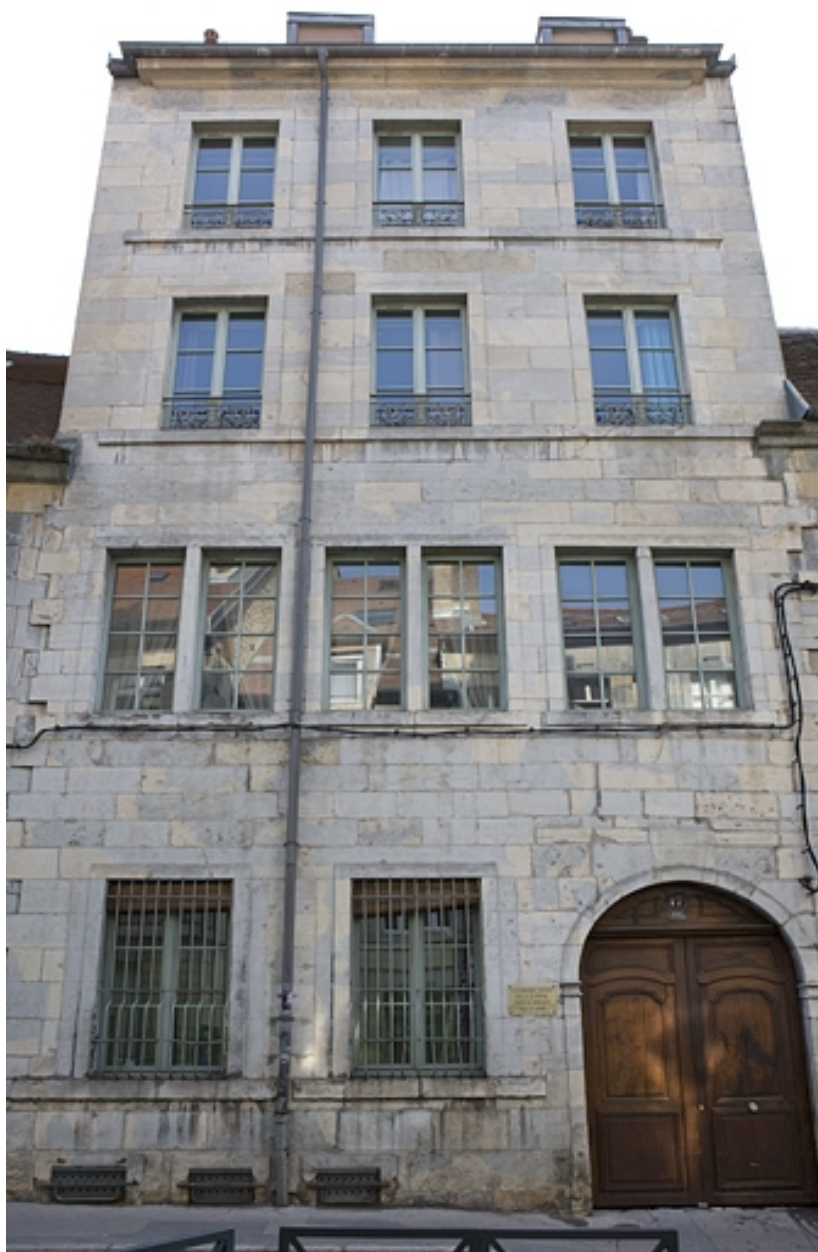
Façade sur rue : de face.
