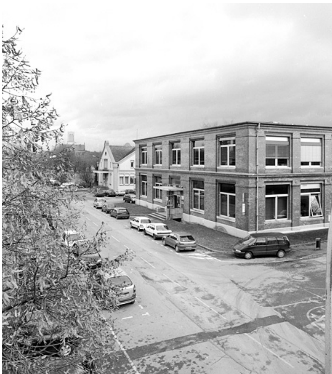
Bureaux et atelier de finissage : vue de trois quarts droite.
