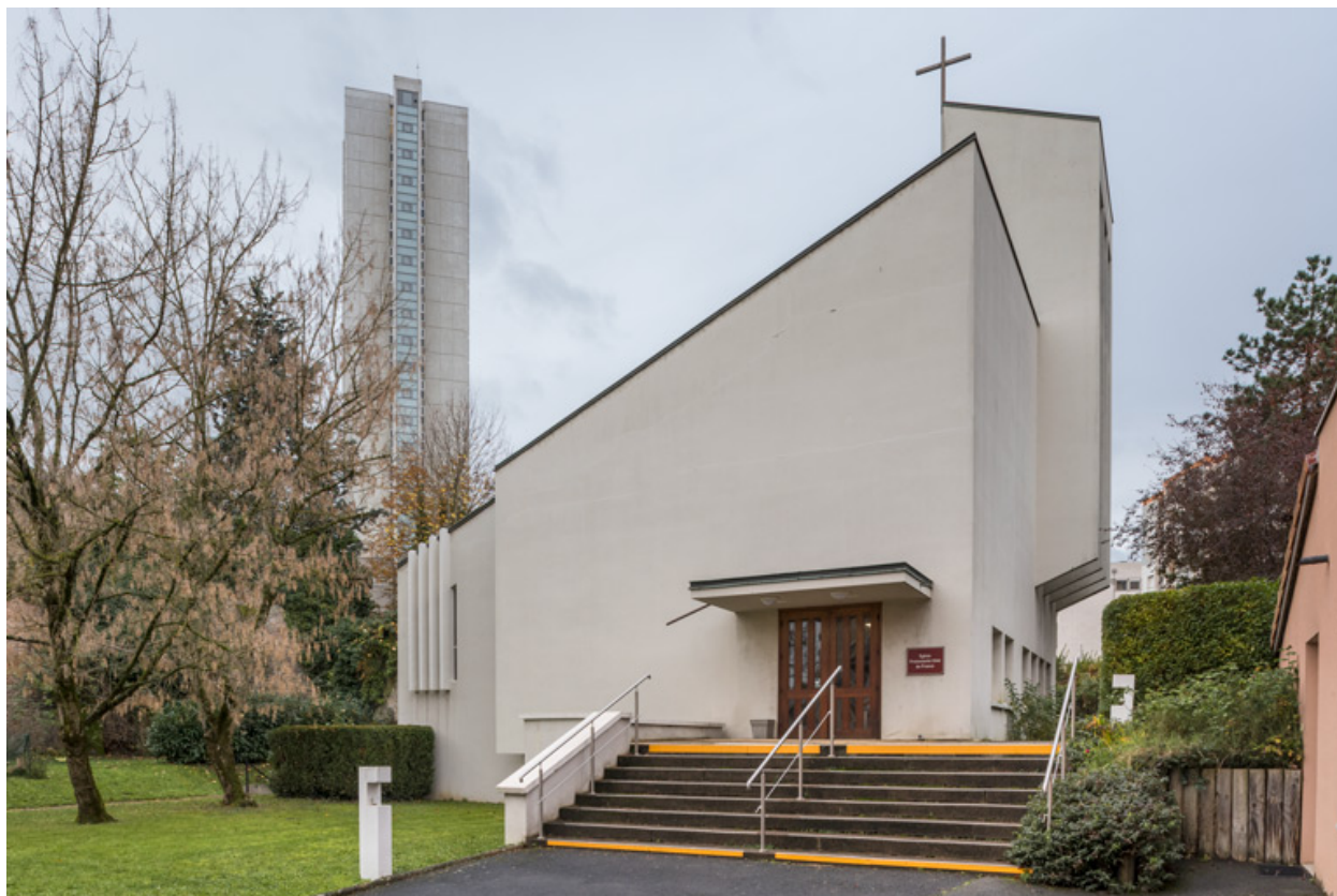
Vue de la façade est.
