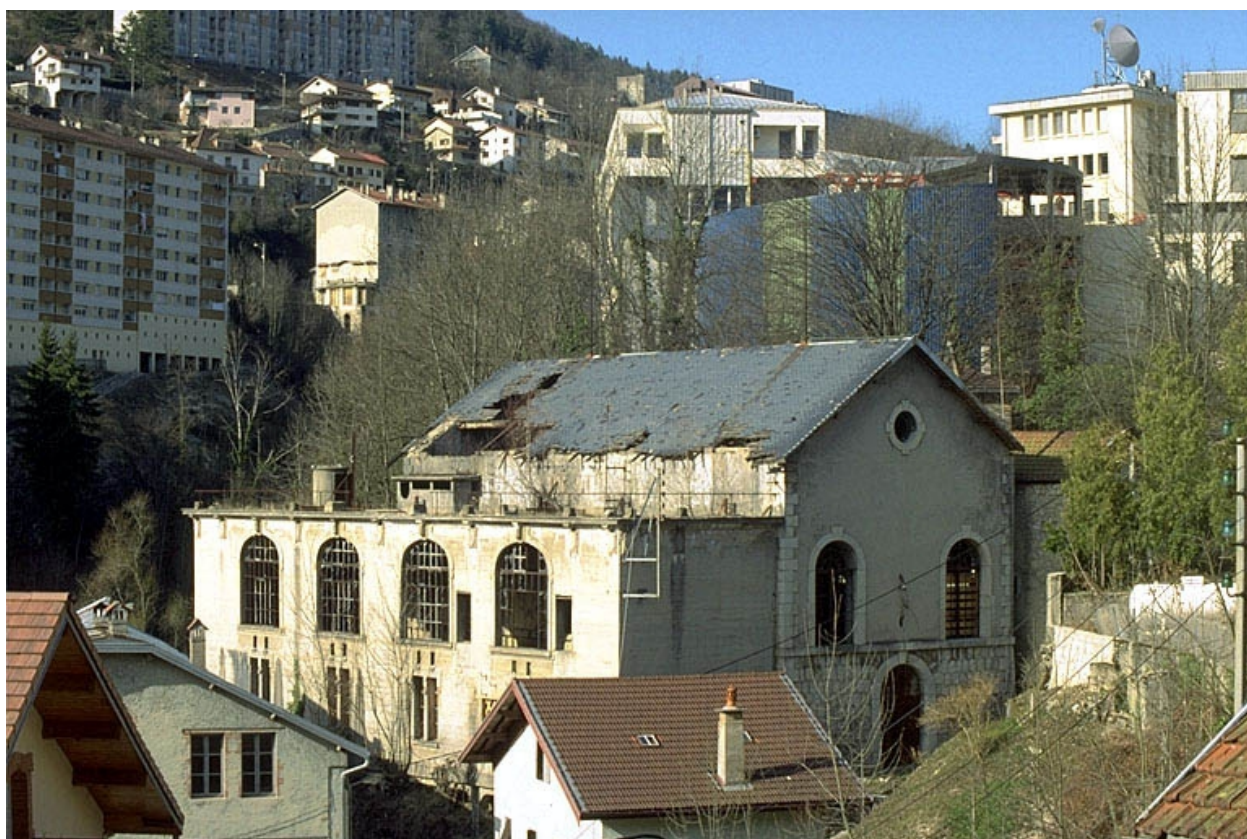
Vue d'ensemble rapprochée depuis le sud.
