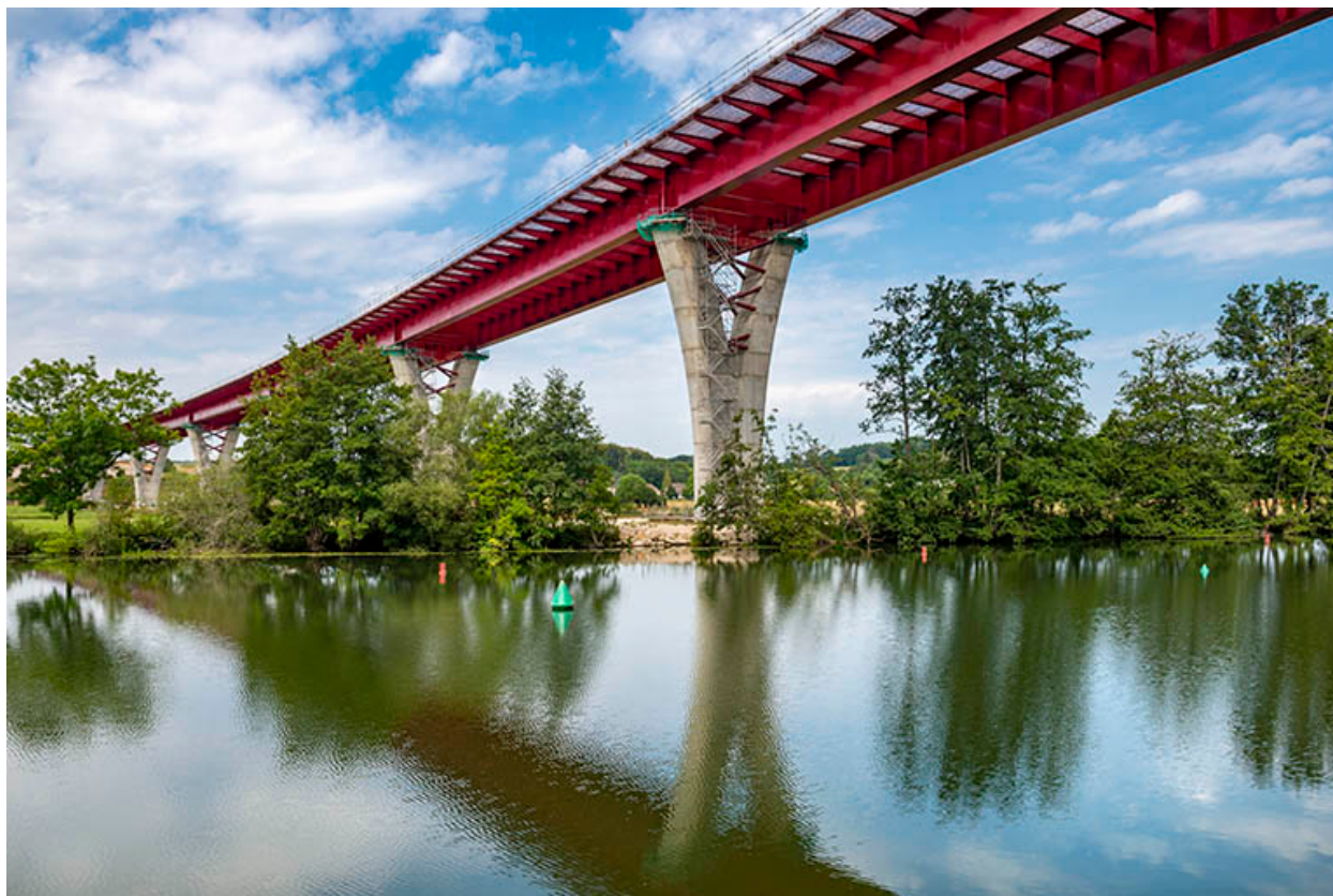
le viaduc en construction (déviation de Port-sur-Saône).
