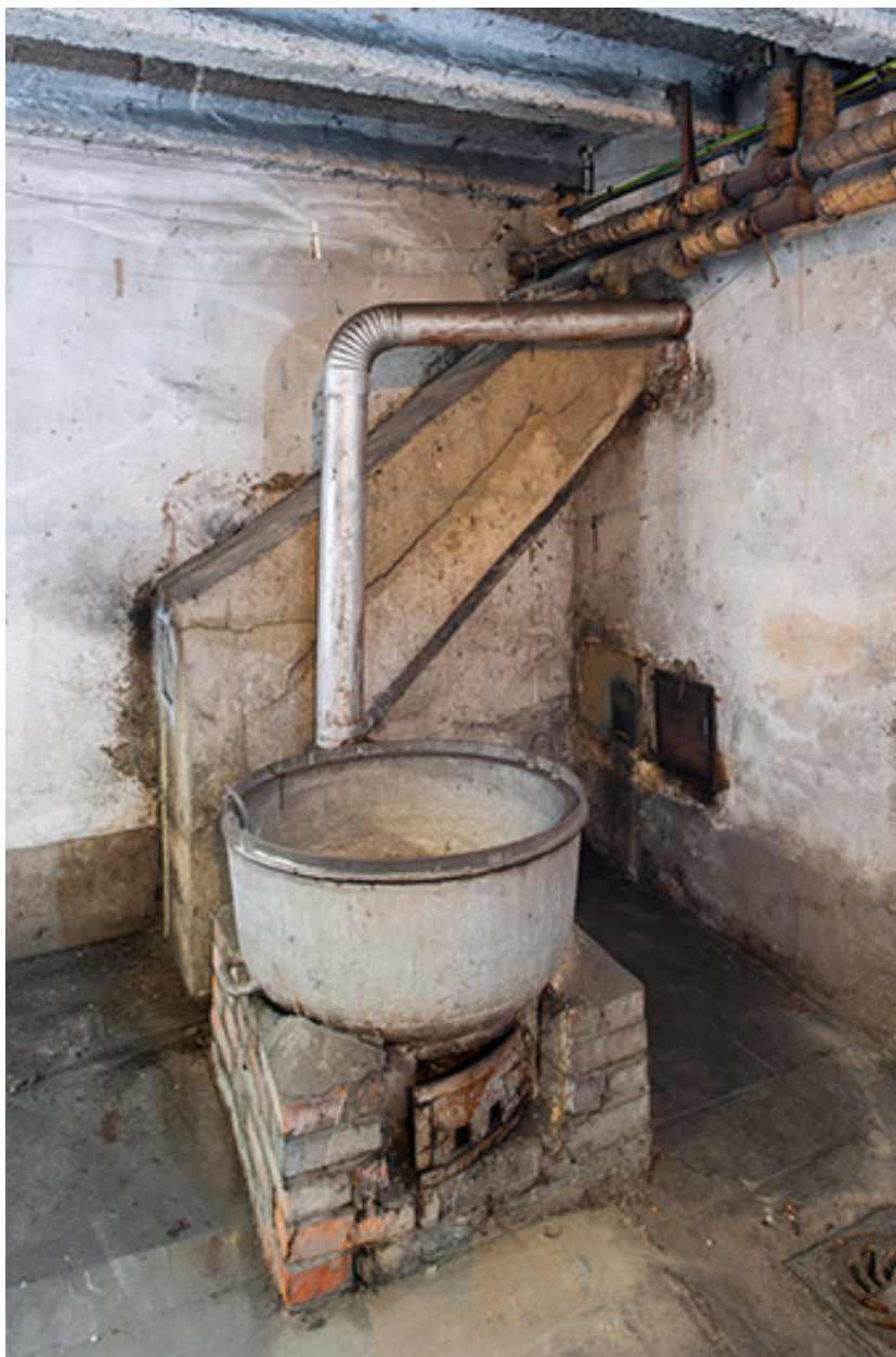
Bâtiment de l'administration, sous-sol : chaudron à lessive.
