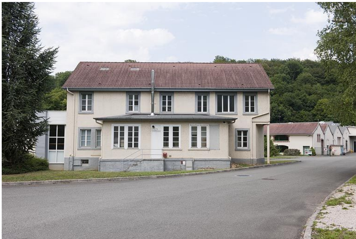
Ancien bâtiment des bureaux. Façade sud.
