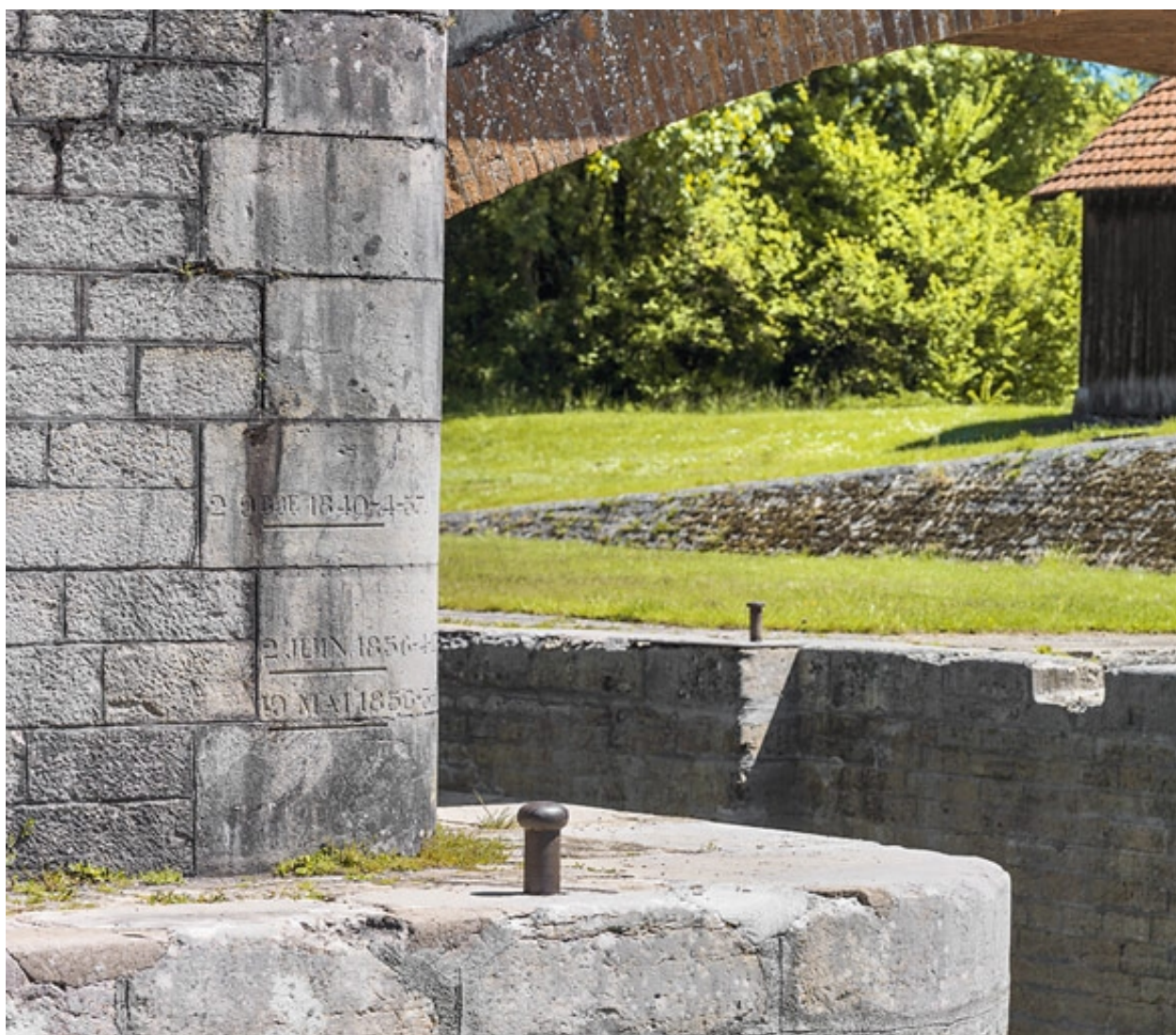
Détail de l'échelle de crue.
