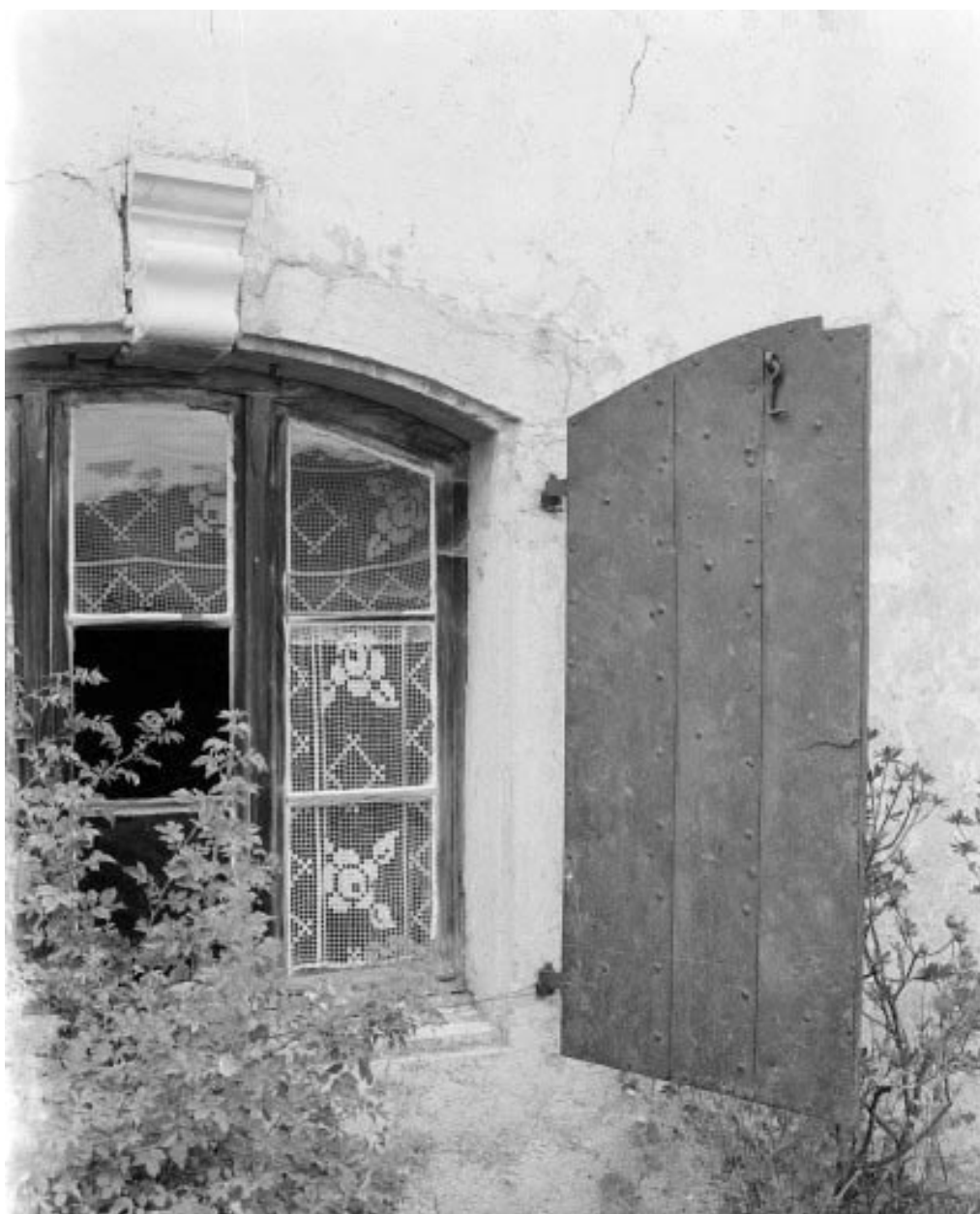
Fenêtre du "carré" : volet ouvert.
