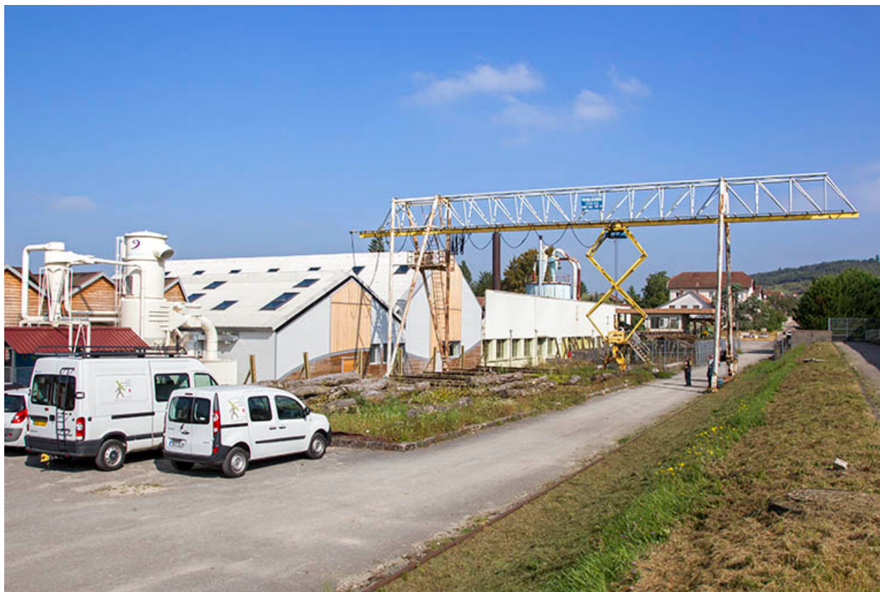
Chantier de grumes.
