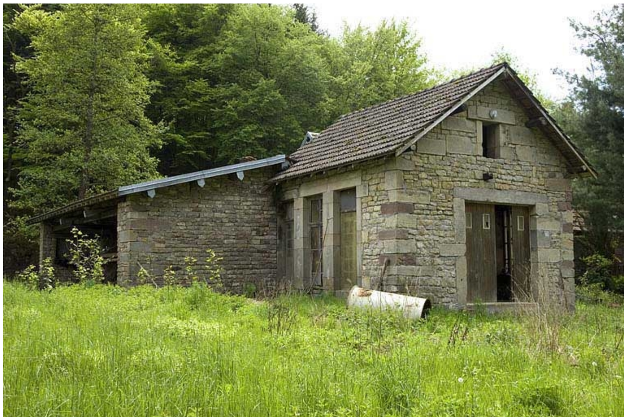
Bâtiment d'eau (local des turbines).
