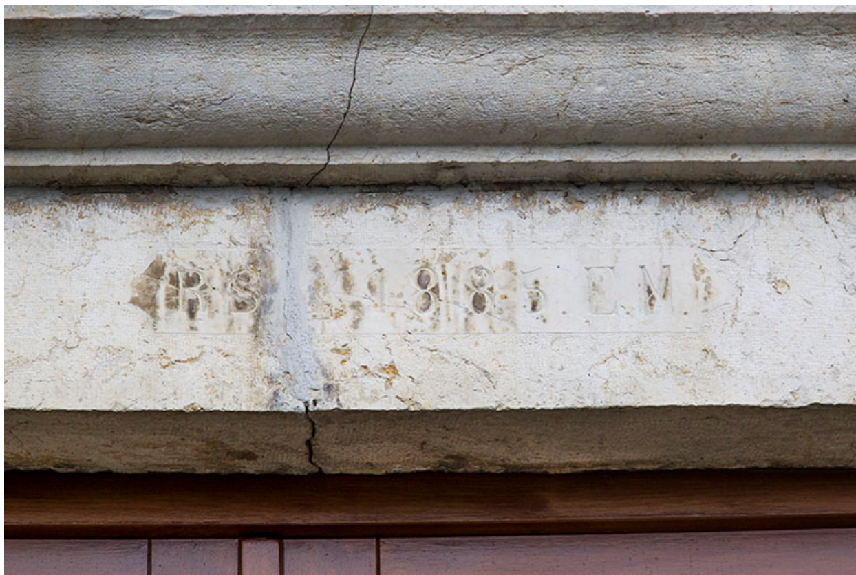
Linteau de l'entrée daté.
