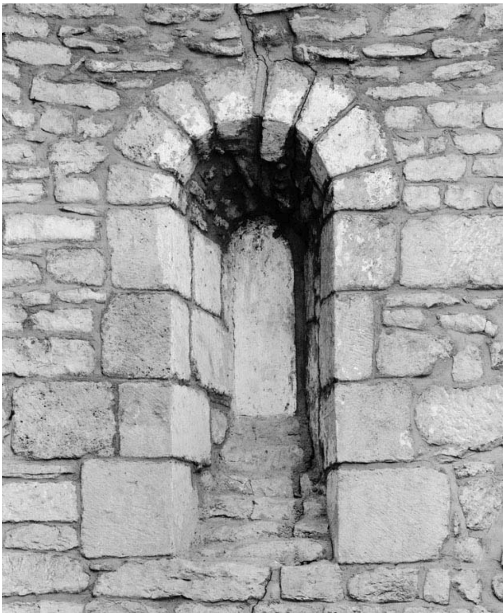
Détail d'une petite baie murée du choeur.
