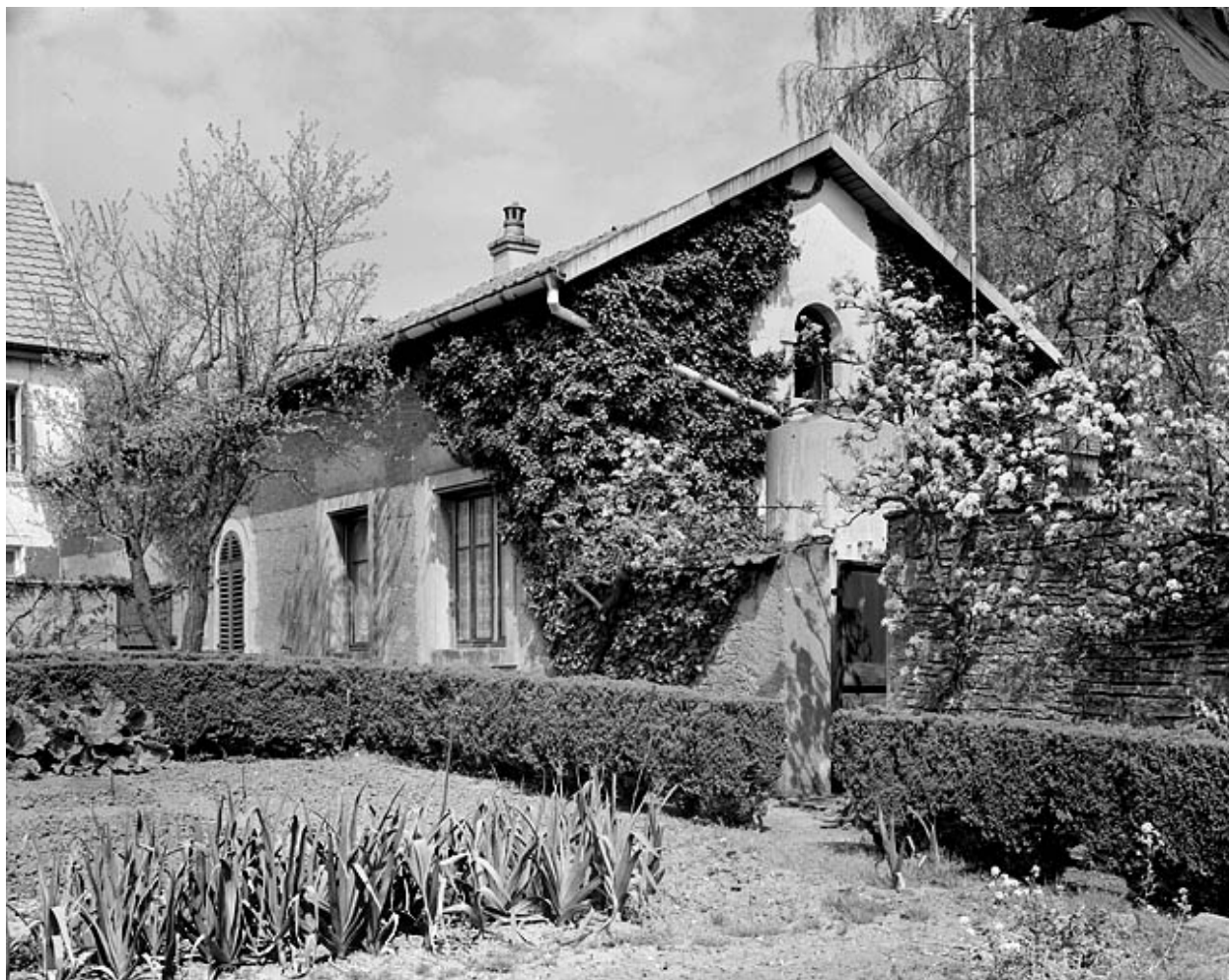
Anciennes écuries. Façades sud et ouest.
